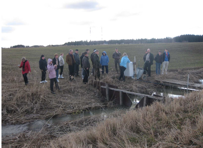
Kuva 2. Kolmiopato hillitsee veden virtausta kosteikon yläpuolisessa valtaojassa. Veden virtauksen väheneminen mahdollistaa kiintoaineen vajoamisen ojan pohjalle. Kyseinen peltoalue on Savijokeen laskevalta valuma-alueelta.
