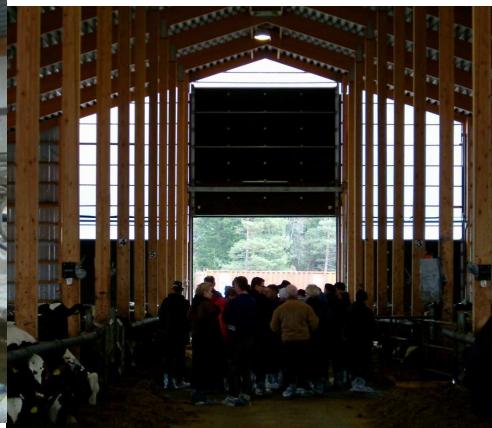
Kuva 9. ja 10. Tilan selkeä ja avara verhoseinäpihatto. Rakennuksen korkeus on 10m ja pituus vajaa 70m ja siihen mahtuu 250 eläintä.
