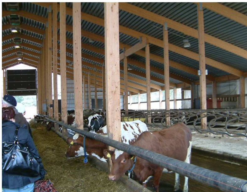
Kuva 9. ja 10. Tilan selkeä ja avara verhoseinäpihatto. Rakennuksen korkeus on 10m ja pituus vajaa 70m ja siihen mahtuu 250 eläintä.
